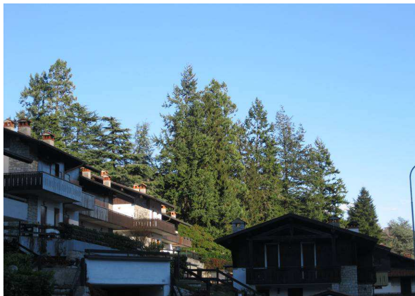
Parco basso – Anfiteatro – Filare 1-7 pericoloso per le strutture abitative
